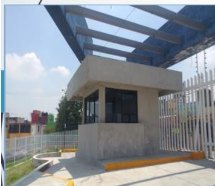
Reparación caseta de vigilancia y guarniciones
